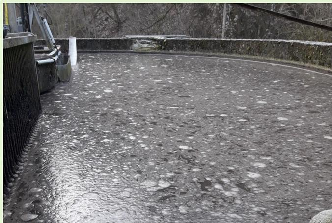
Becken der Kläranlage Rosenberg mit aufschwimmendem Fett
